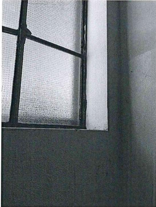
Tripperia bovini: le finestre sono dotate di davanzale interno (accumulo di polvere)
