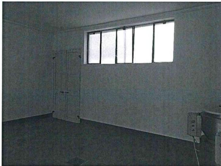
Tripperia ovini (finestra con davanzale interno e porta con battente sul massetto del cortile)
