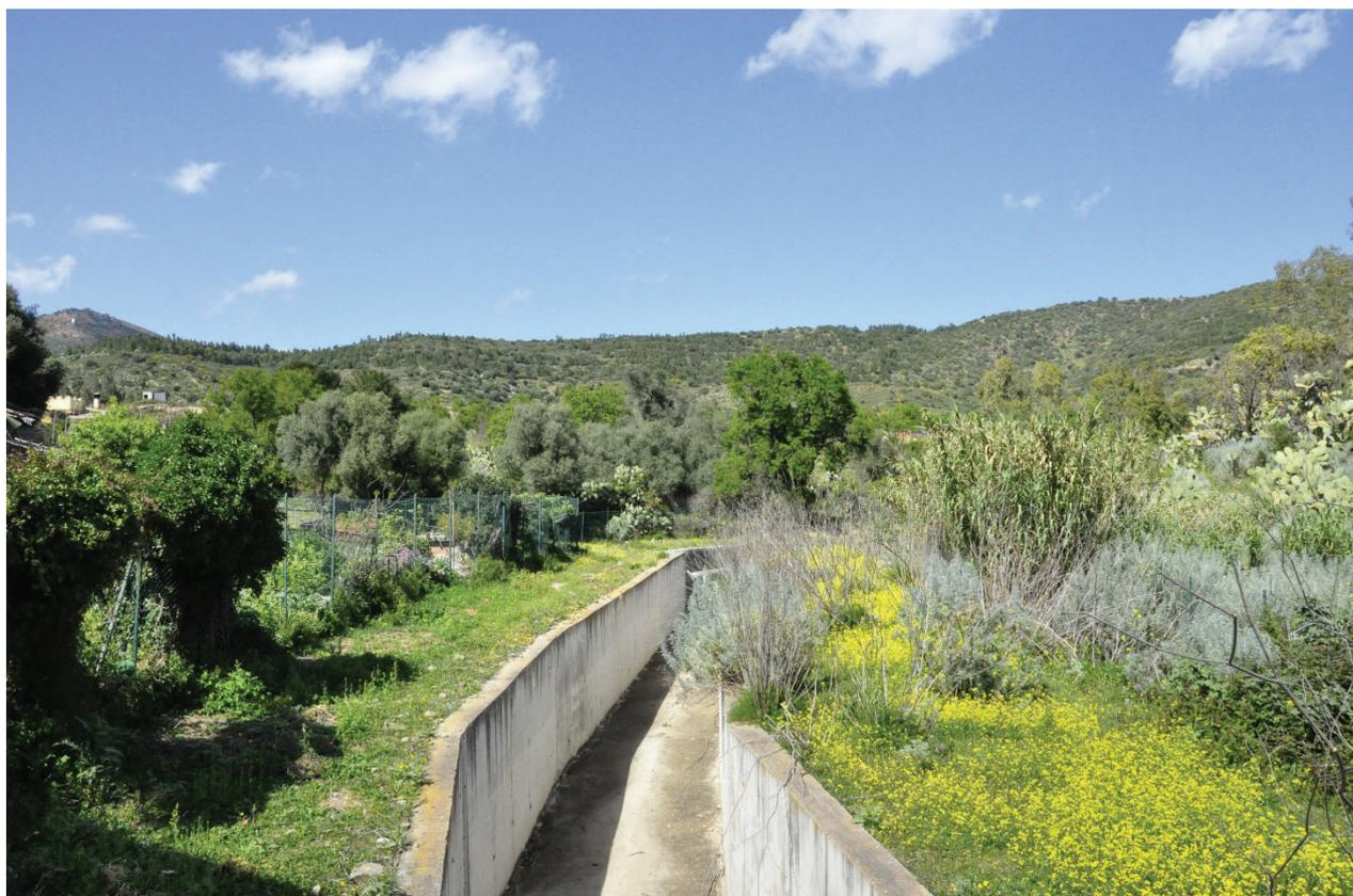
Figura 14 - Fotografia **V410**. Opera idraulica di regimazione delle acque connessa con il canale tombato posto al di sotto della Via La Marmora
