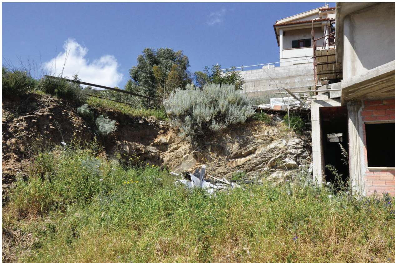
Figura 3 – Fotografia V403 . Taglio stradale in cui è possibile notare il substrato roccioso sovrastato da una esigua coltre di detriti
